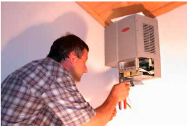
Montage Wechselrichter, Foto "die umweltberatung"
