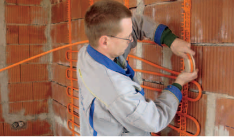
Verlegung der Heizfläche einer Wandheizung
