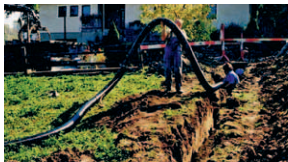
Erdverlegte Nahwärmeleitung vor dem Zuschütten der Künette
