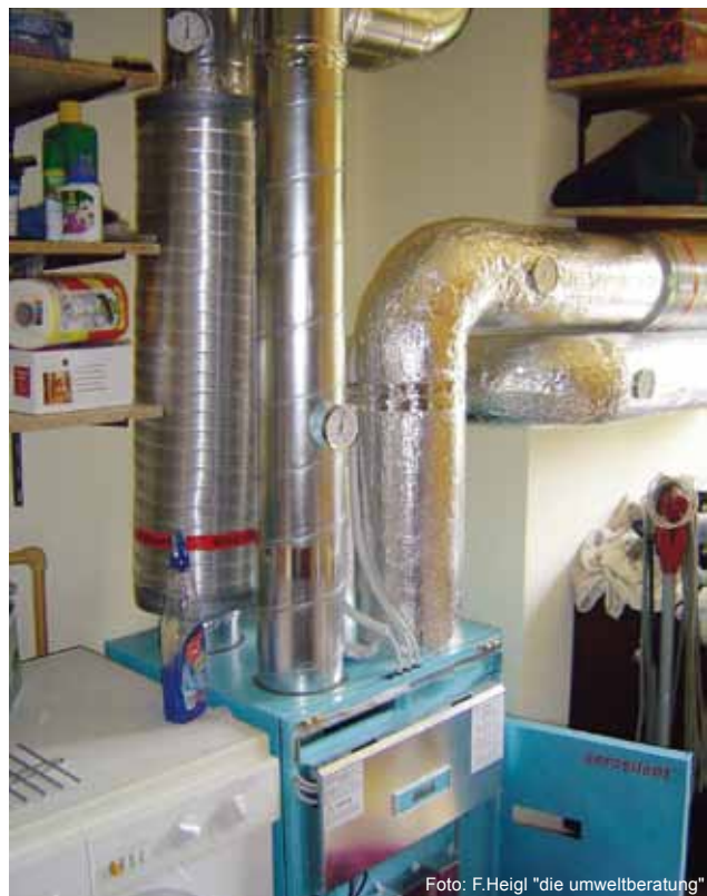
Eingebautes Lüftungsgerät einer Wohnraumlüftungsanlage mit Wärmerückgewinnung
