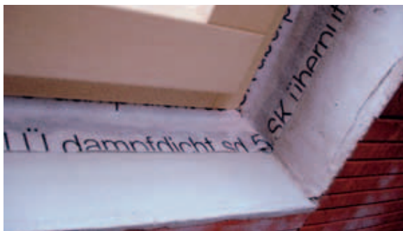
Luftdichter Einbau mit Glattstrich und Klebefolie
