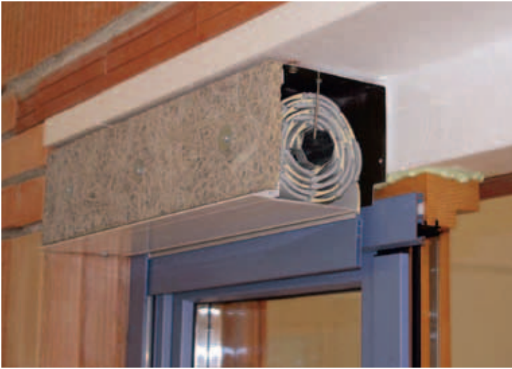
Wärmebrückenfreier Einbau eines Rollladens
