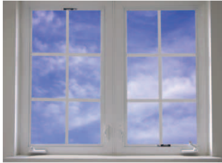
Fenstersprossen werden nur aufgesetzt und sollten das Glas nicht teilen.
