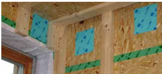
Sorgfältiges Abkleben mittels Dichtband
